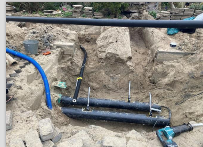
Huisaansluiting warmtenet in aanleg (bron: warmtenetgorinchem.nl)
