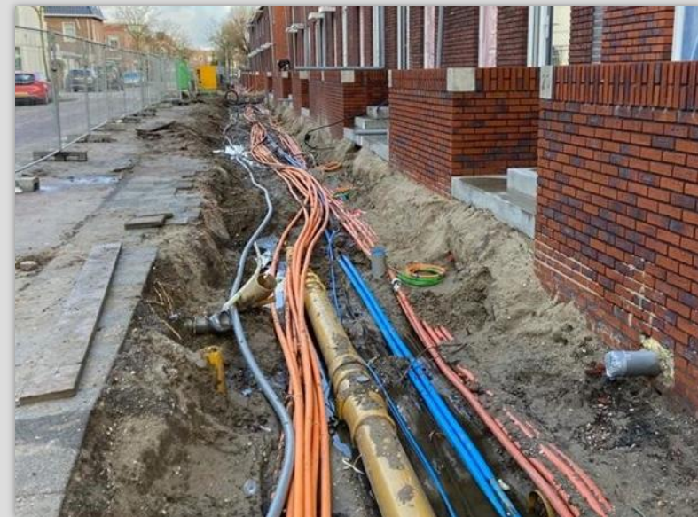
Diverse kabels en leidingen in de straat (bron: Bouwend Nederland)
