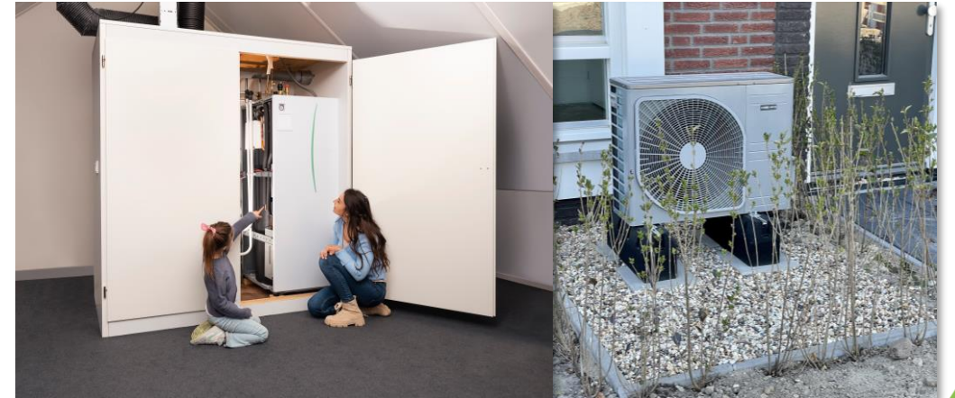
Binnendeel warmtepomp en buffervat
