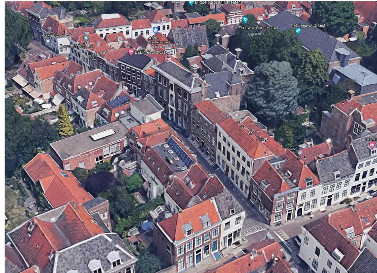
Koepoortstraat, Middelburg: aaneengesloten monumenten met - voornamelijk - woonfunctie en (beperkte) tuinen.
